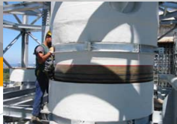
Muffenverbindung
